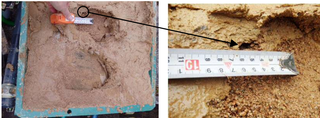
図-6 水の噴出し箇所で確認されたパイピングホール
